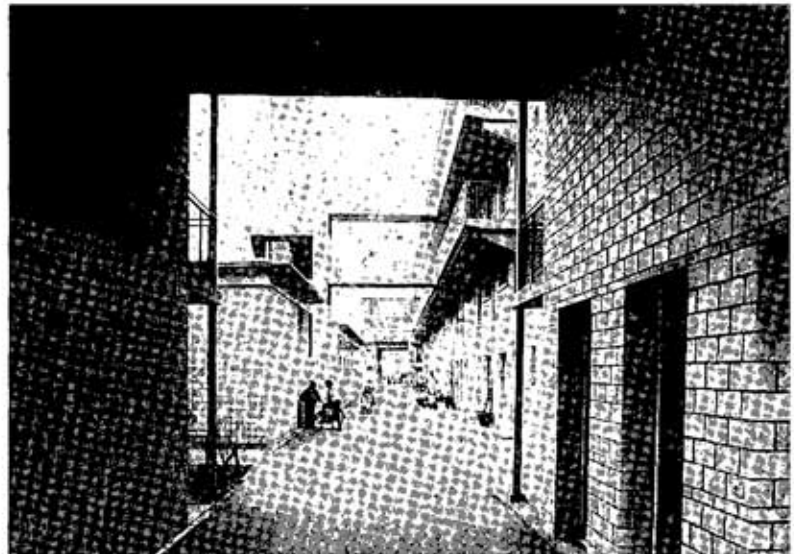
Abbildung 8: Die Hofgasse: Das Hofgebäude und die dar verbundene Hofgasse trennen den nördlichen vom südlichen Hof
