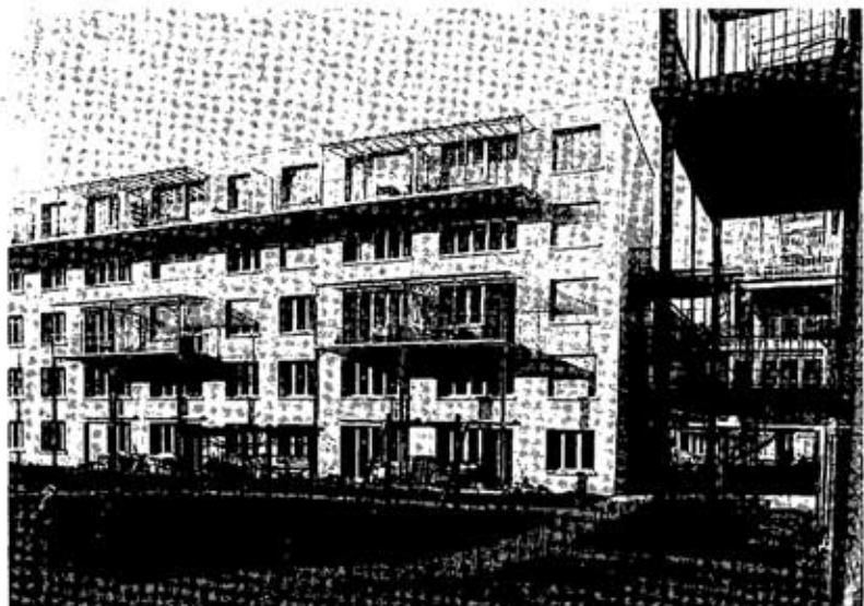
Abbildung 12: Anschluss des Hofgebäudes an die Randbebauung mit Veranden; Blick gegen Nordwesten
